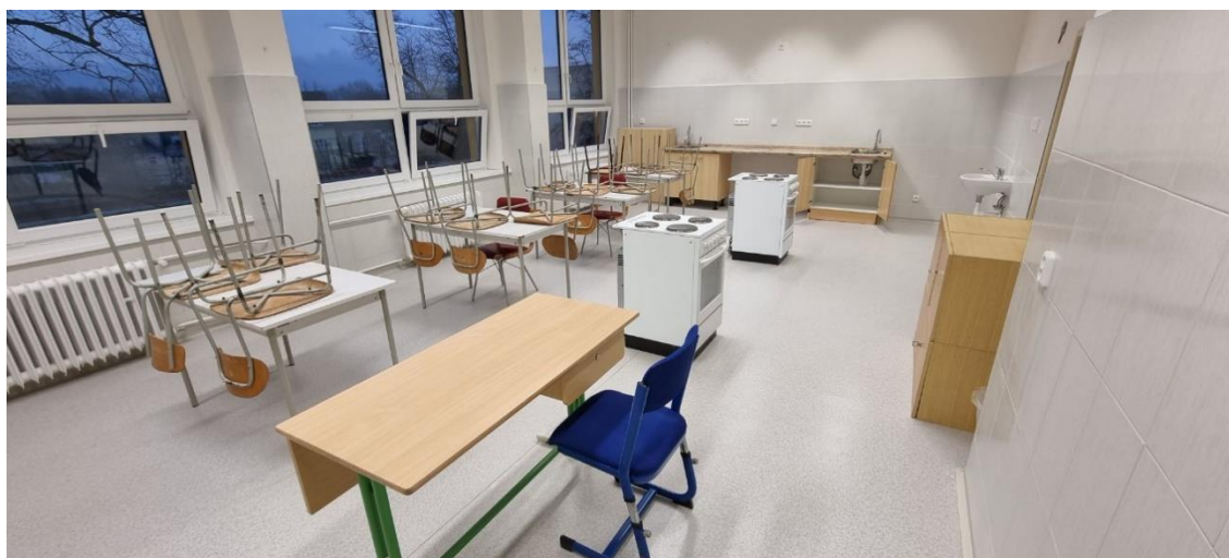
Foto: Probíhající rekonstrukce kuchyňky ve spolupráci se SRPŠ.
